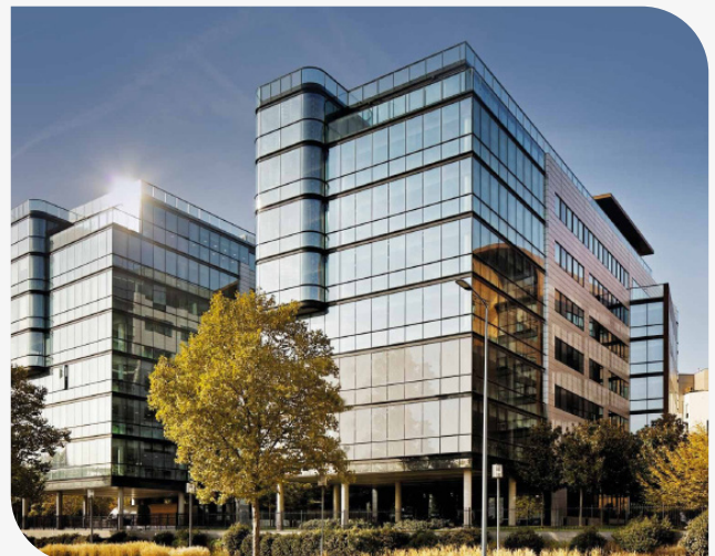
Immeuble « Seine Avenue »
